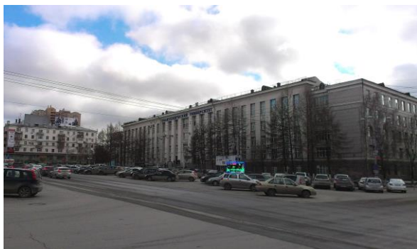
Главный корпус ПНИПУ
